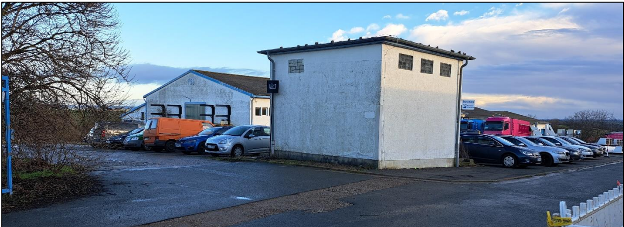
Abbildung 9: Blick auf das Plangebiet von Südwesten
