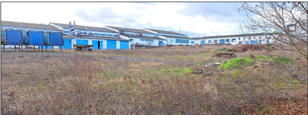
Abbildung 10: Blick auf das Plangebiet von Nordosten
