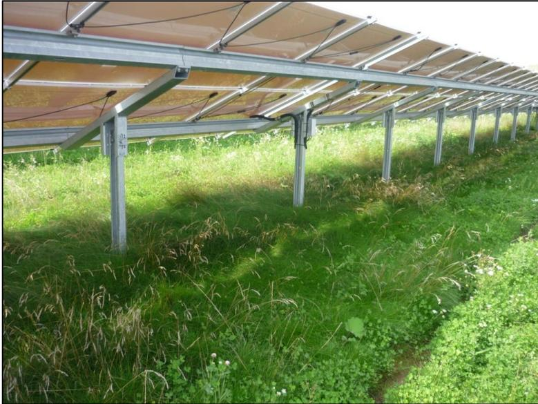
**Abbildung 7:** Beispiel der Aufständigung von Solarmodulen (Bereich Solarpark Ronneburg Süd).
