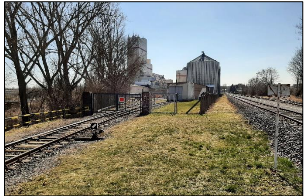
Abbildung 9: Gleisanlage und östliche Laubbaumgruppe (Blick von Norden)
