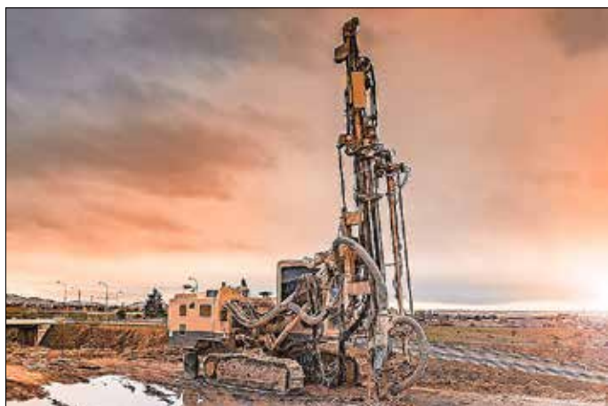
Bohrgerät auf einer Baustelle Foto: Adobe Stock 2024
