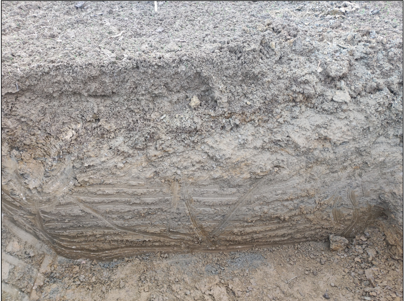
Foto 4: Schurf 2, Blickrichtung Süden
