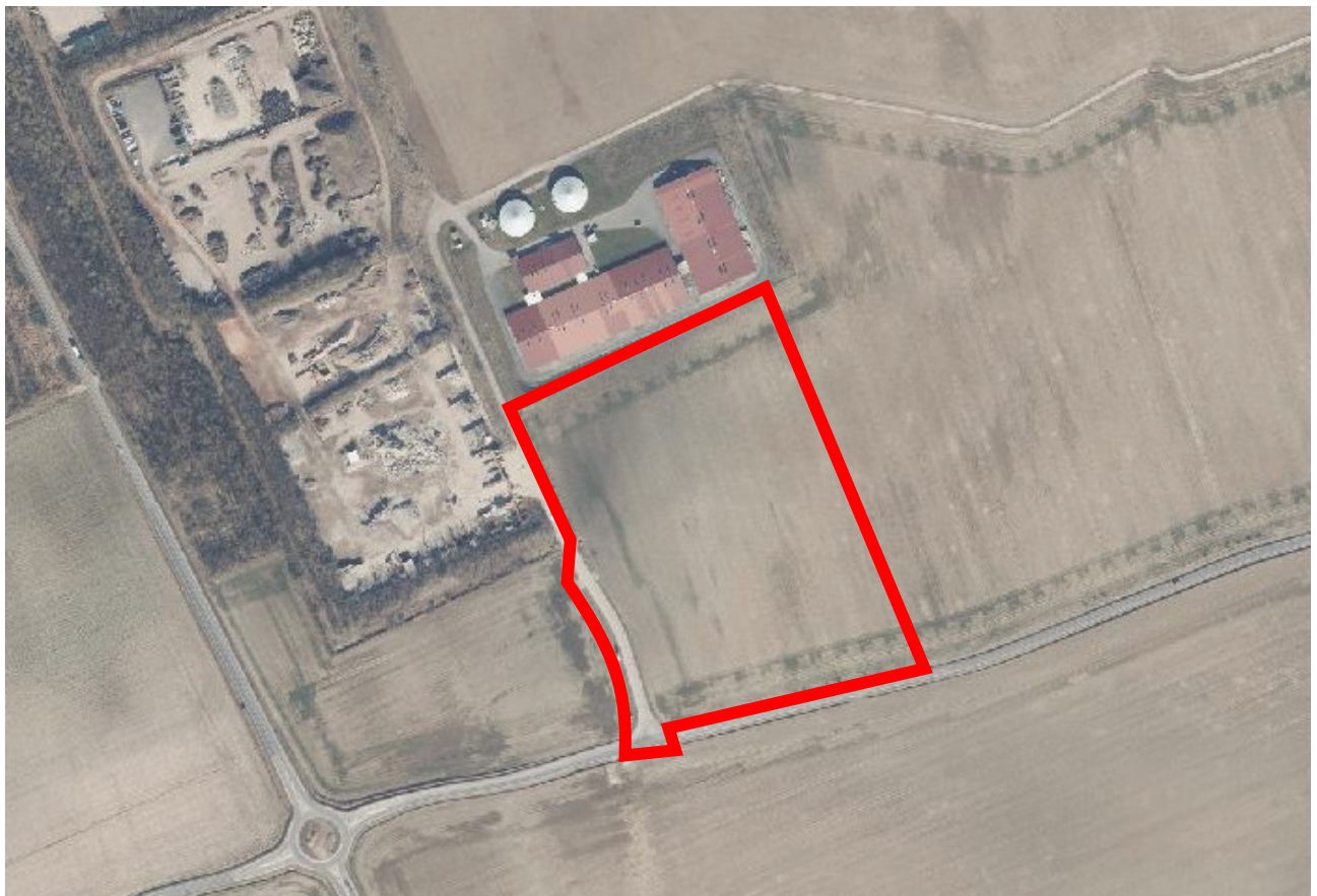
Abbildung 3: Luftbild des Anlagenbereiches
